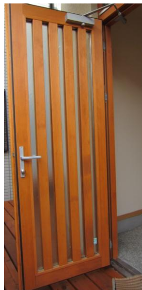
両面格子ドア 防犯性に優れ、気密性を重視したドイツ製3点ロック金物を使用しています。 このドアは、内外両面に格子がある仕様で、防犯複層ガラスが入っています。
